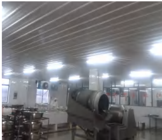
车间LED灯更换
